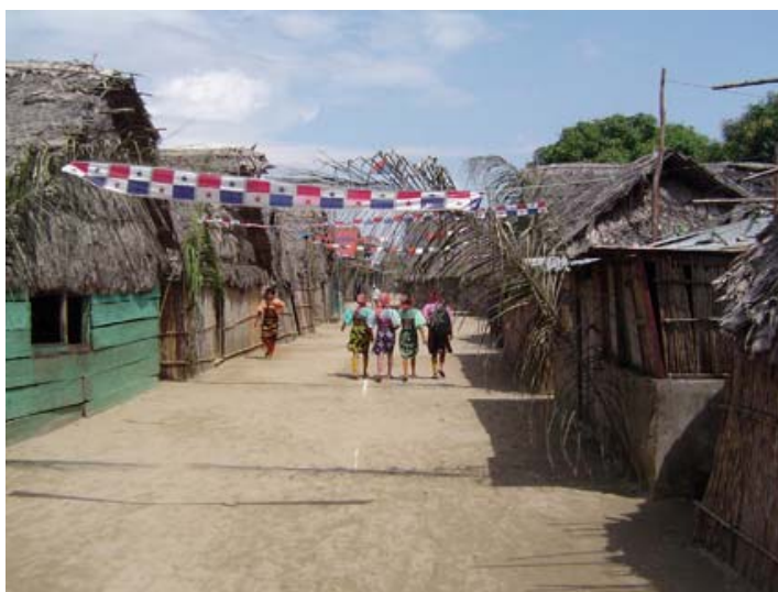
Calle y vivienda en isla Río Sidra. Fotografía digital de los autores.
